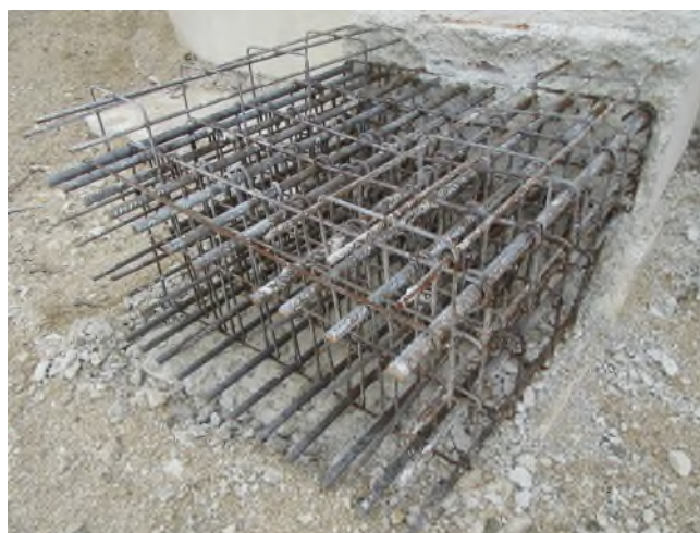
Exemple d'une amorce de longrine existante découpée au disque diamant, avec destruction du béton par la technique d'hydrodémolition.
