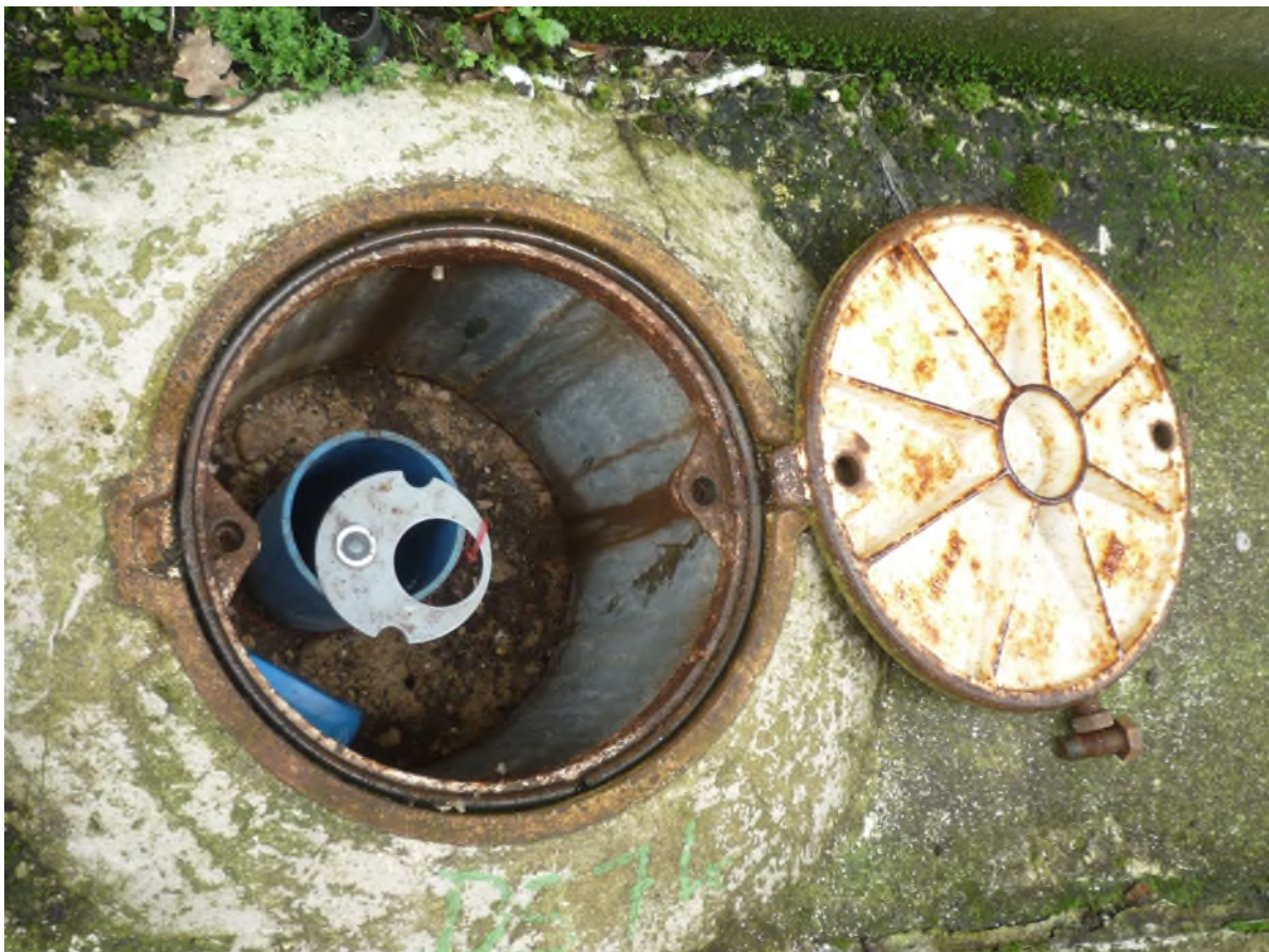
Tube du piézomètre instrumenté
